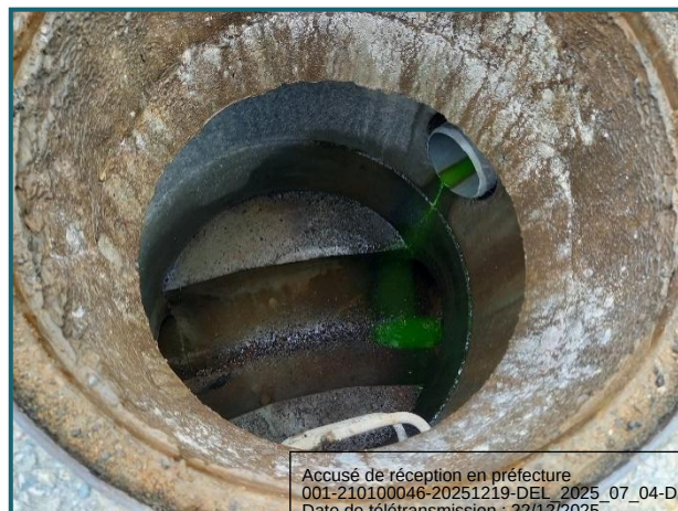
Eau teintée avec de la fluorescéine, utilisée pour repérer les branchements d'assainissement, particulièrement en cas de regards d'assainissements
