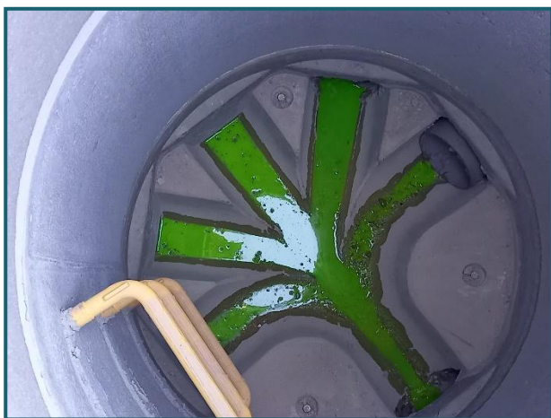
Eau teintée avec de la fluorescéine, utilisée pour repérer les branchements d'assainissement, particulièrement en cas de regards d'assainissements
