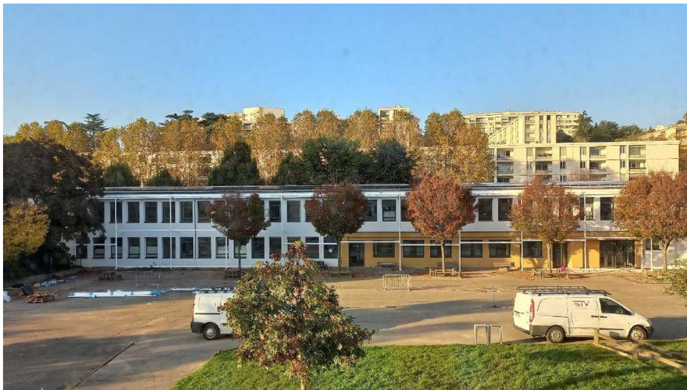
Groupe scolaire Diderot à Lyon
