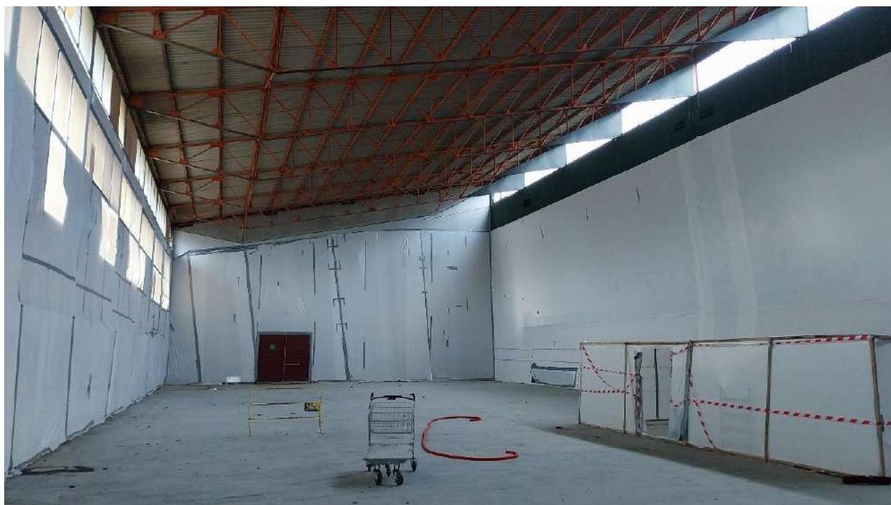
Gymnase Malherbe à Grenoble – Phase désamiantage
