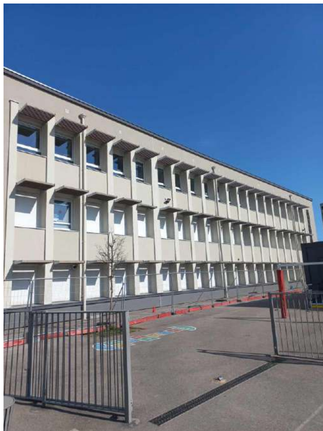
Groupe scolaire Moulin pour la Ville de Villeurbanne Objectif de réduction des consommations énergétiques de 39%
