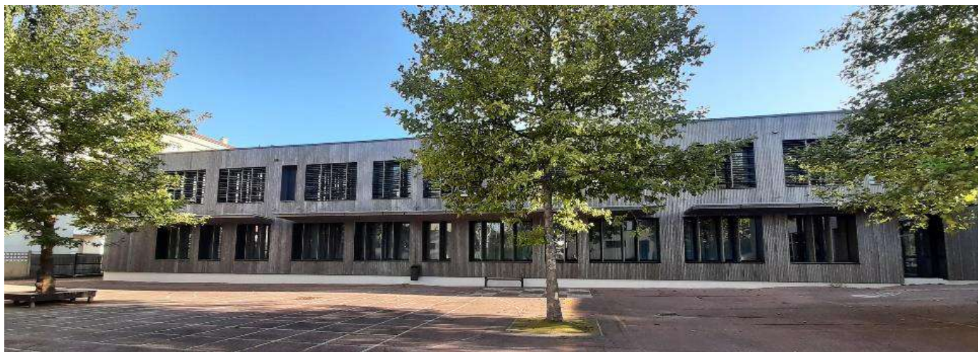
Groupe scolaire Gémeaux à Lyon
