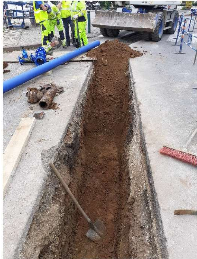
Tranchée MDTP - Avenue Sarrail
