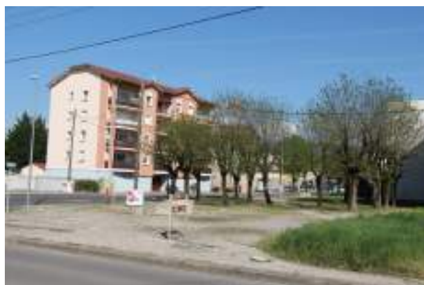
Immeuble d'habitation Dynacité av. Général Sarraill
