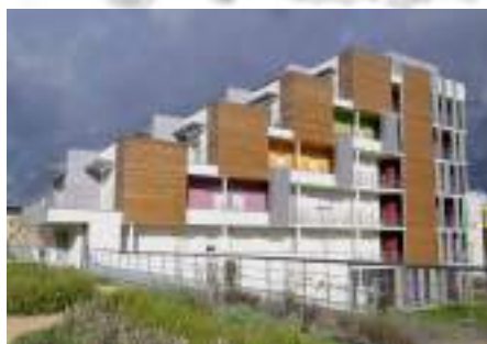
Exemple de façade en gradin
