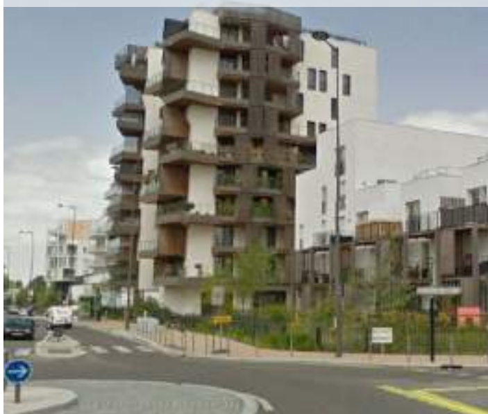
Exemple de façade qualitative d'immeuble repère
