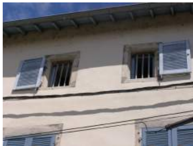
Détail sur ouvertures
