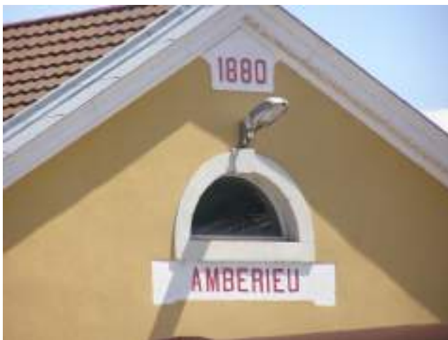
Détail de la façade nord de la salle d'attente
