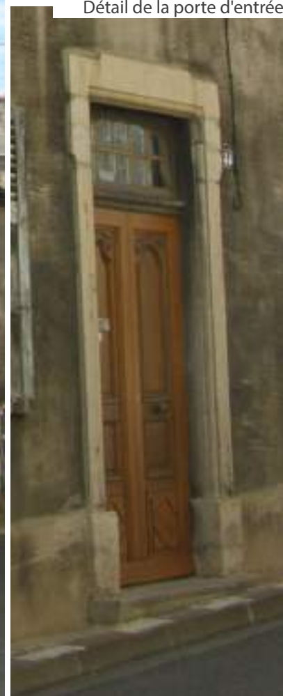
Détail de la porte d'entrée
