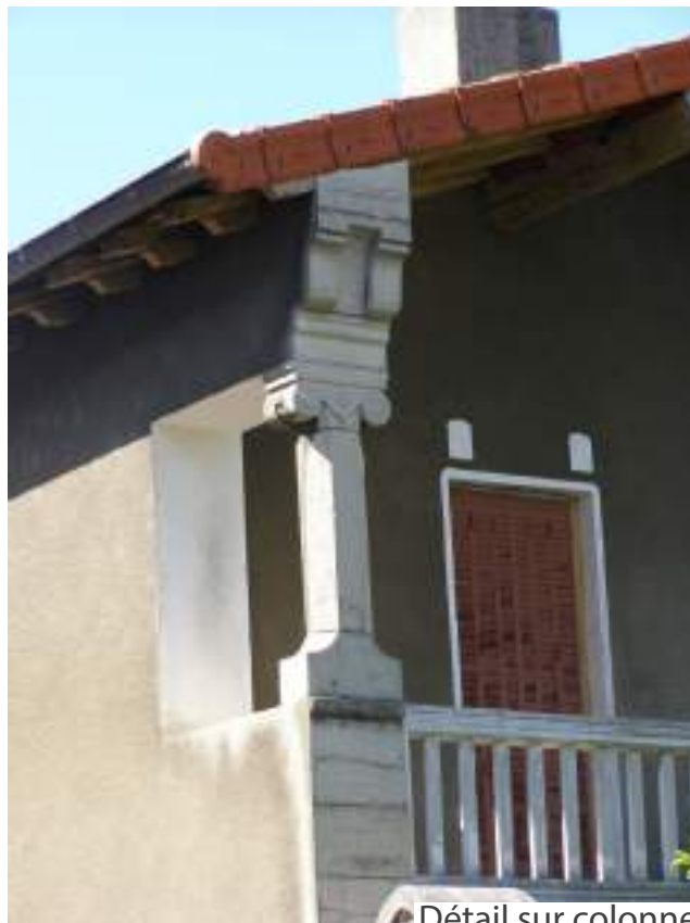
Détail sur colonne
