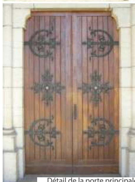
Détail de la porte principale
