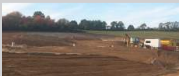
Terrassements importants pour l'implantation d'activités
