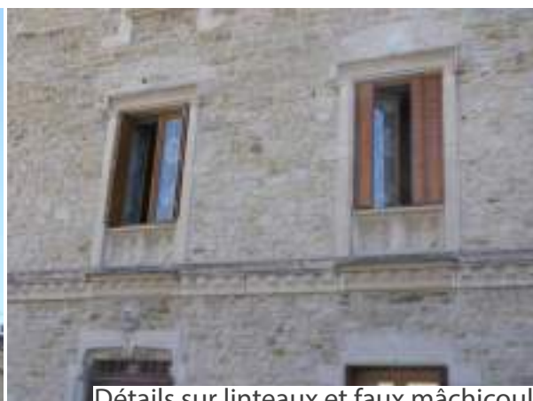
Détails sur linteaux et faux mâchicoulis
