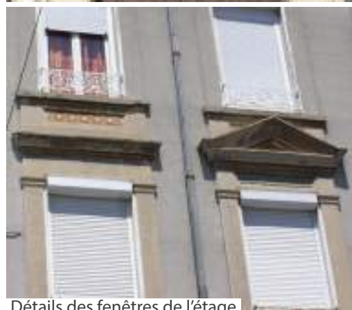
Détails des fenêtres de l'étage
